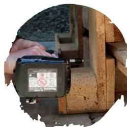
Schrauben Sie hier oben und unten je eine Schraube hinein (Seitenansicht linke Rückenlehne, Frontansicht auf die beiden anderen)
